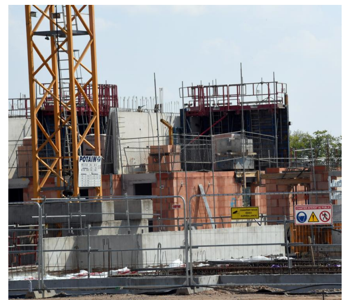
En construction, la ZAC de la Scierie à Brumath sera la première smart city du Bas-Rhin. Les premiers logements seront livrés en septembre. PHOTO DNA - JEAN-CHRISTOPHE DORN
